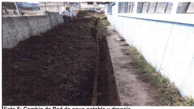
Foto 5: Cambio de Red de agua potable y drenaje .
