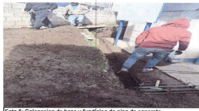
Foto 6: Colocacion de base y fundicion de piso de concreto.
